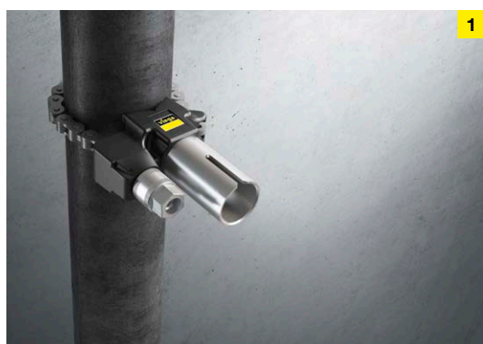
1. Eine spezielle Bohrführung zur Führung der Bohrwelle wird am Stahlrohr befestigt.
