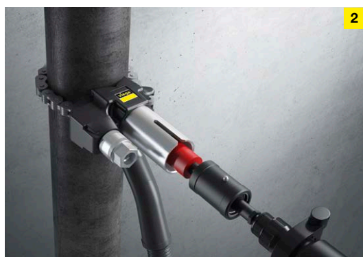
2. Bohrung mit der Bohrmaschine durchführen und Bohrführung wieder abnehmen.
