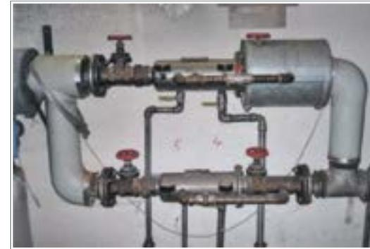
Abb. 16: Filteranlage (redundante Ausführung)
