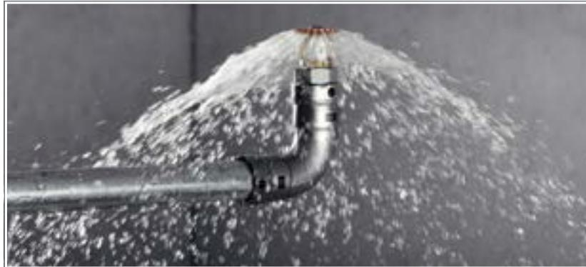
Abb. 32: Viega Megapress in einer Sprinkleranlage
