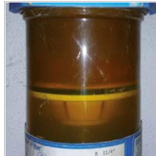
Abb. 17: Filter am Hauseingang ohne Wartung und Inspektion
