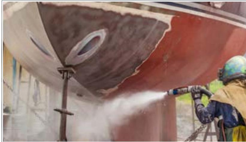
Abb. 45: Blasluft beim Sandstrahlen
