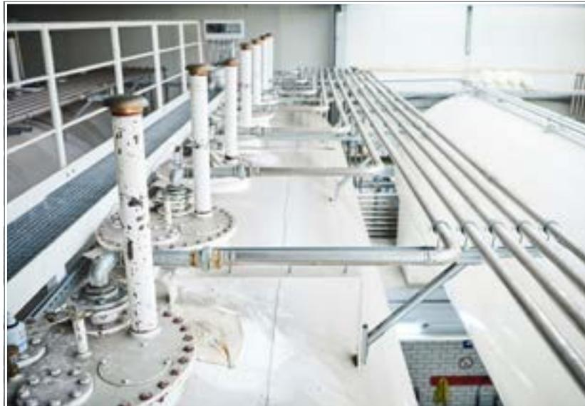
Abb. 99: Befüllen und Entleeren von Kühlschmiermitteltanks mit Viega Sanpress Inox G
