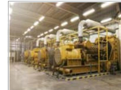
Abb. 95: Dieselmotorendes Notstromaggregat
