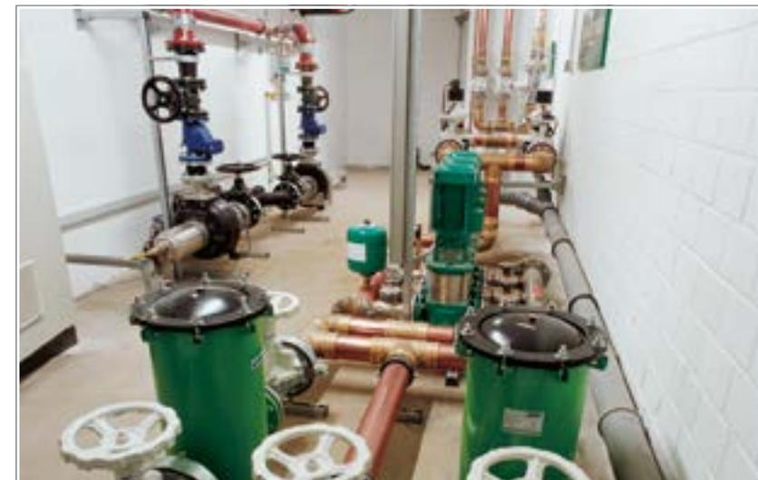
Abb. 26: Viega Rohrleitungssystem Sanpress XL in einer Wasseraufbereitungsanlage
