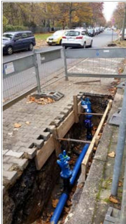
Abb. 10: Durch Umwelteinflüsse, wie gestiegene Oberflächentemperaturen, wird das Trinkwasser mittlerweile schon auf dem Weg zum Hausanschluss deutlich stärker erwärmt, als dies noch vor einigen Jahren der Fall war. Ein beträchtliches Risiko für den Erhalt der Trinkwassergüte! (Foto: Martin)
