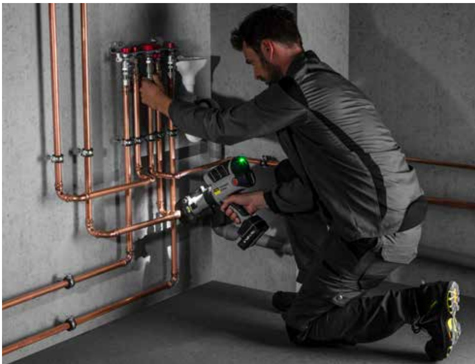
Die Pressgun 6 Plus ermöglicht ein schnelles und flexibles Arbeiten in jeder Lage.
