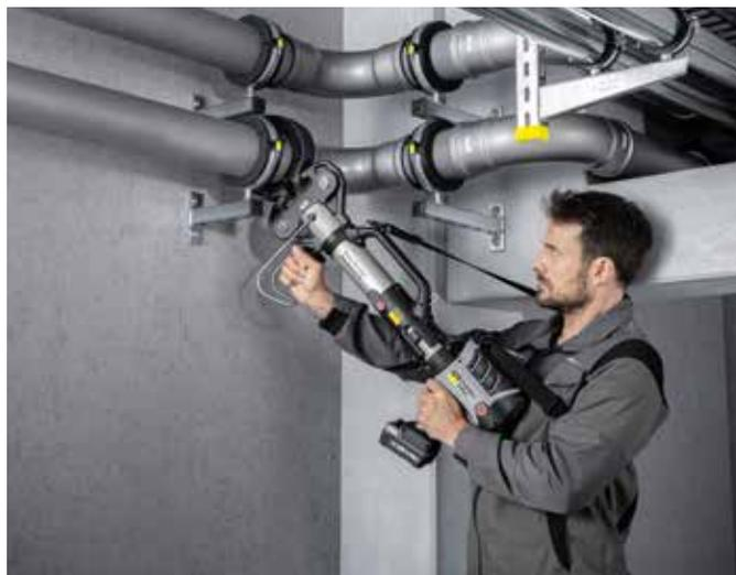
Das Megapress S-Pressverbindersystem bietet mit den Dimensionen bis 2 Zoll eine optimale Anbindungsmöglichkeit (nach AGFW FW 524) an Nah- und Fernwärmenetze. Ab dem Gebäudeeintritt können die dort häufig eingesetzten dickwandigen Stahlrohre schnell und sicher verpresst werden.
