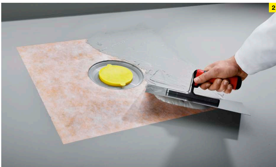
Auftrag der 2. Abdichtungsschicht mit einer in der Baupraxis bewährten Zwei-Komponenten-Kunststoff-Zementmörtel-Kombination.
