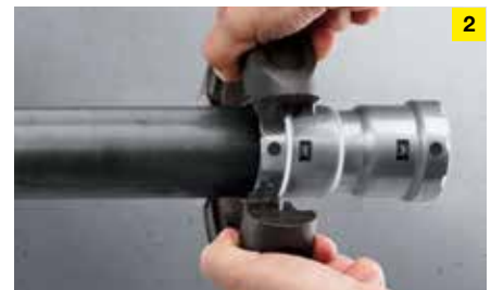
Zur Verpressung von Megapress-Verbindern ab 1\frac{1}{4} Zoll werden ausschließlich Pressringe mit Gelenkzugbacke verwendet. In kleineren Dimensionen zwischen \frac{3}{8} und 1 Zoll stehen sowohl Pressbacken als auch Pressringe mit Gelenkzugbacke zur Wahl.
