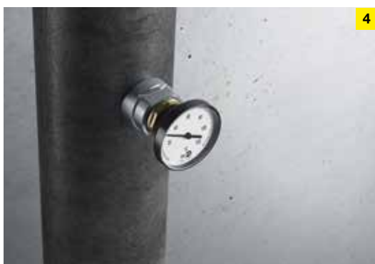
4. Fertig ist der ideale Stahlrohr-Anschluss beispielsweise für Thermometer, Manometer oder Entleerungen.
