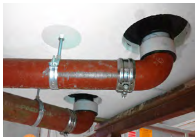
Abb. 173: Guss/HT-Verbinder / Advantix Brandschutzablauf
