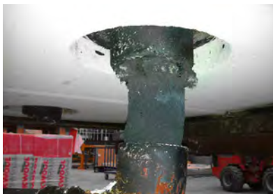
Abb. 174: nach Brandversuch - Gussleitung verschlossen
