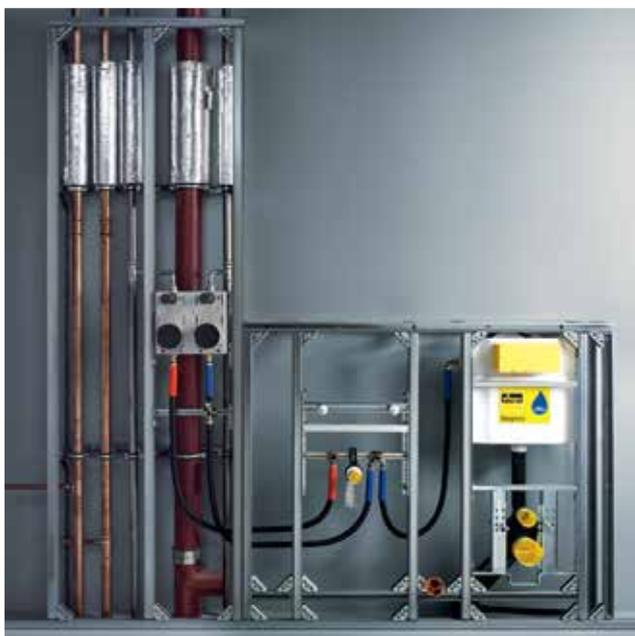
Abb. 53 Schachtbelegung
