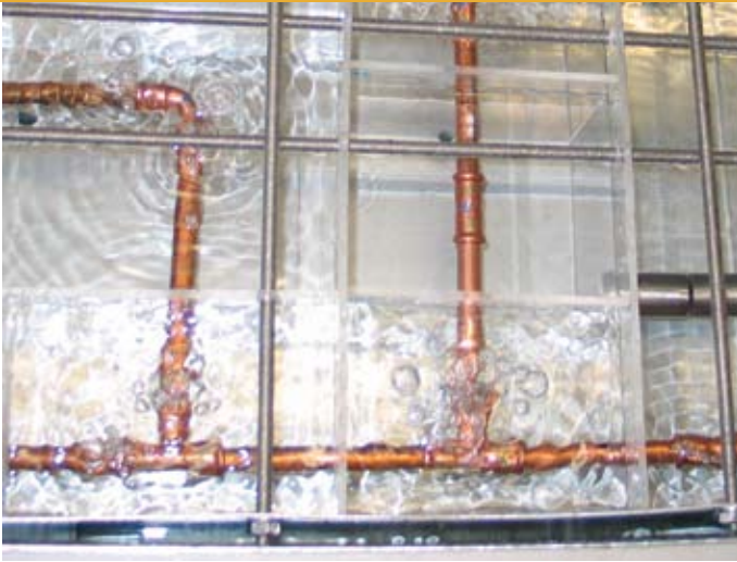
■ Bild 4: Laufender Versuch mit Druckluft, zwei Verbindungen sind sichtbar dicht.
