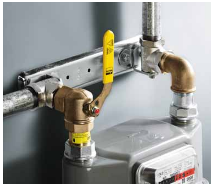
Gasströmungswächter Typ K: in der Gaszählerverschraubung für den Einbau senkrecht nach unten
