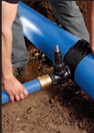
Hausanschlussleitung verlegen.
