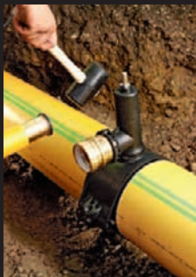
Hausanschluss- leitung verlegen.
