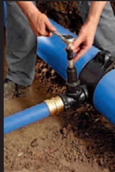
Betriebsabspernung öffnen. Fertig.
