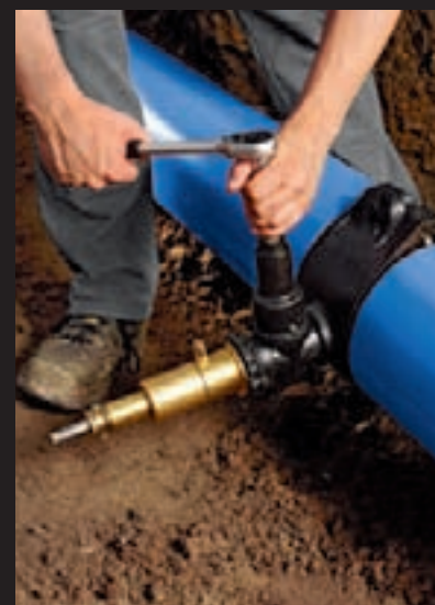
Betriebsabsper- rung schließen.
