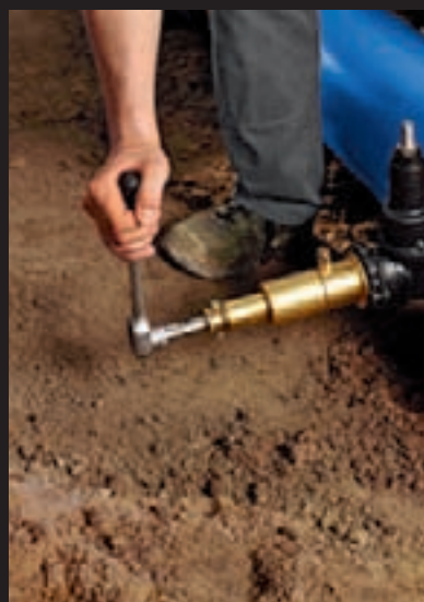
Nach Druckprobe anbohren.
