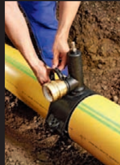
Abgangsstutzen sichern.
