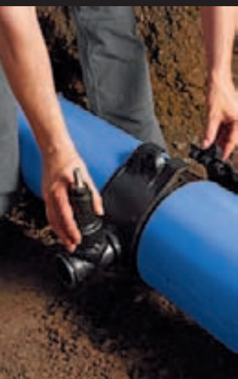
Anbohrarmatur aufsetzen.
