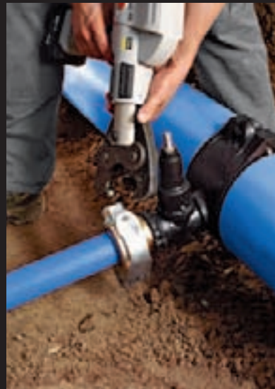
Anschlussleitung verpressen. Druckprobe.
