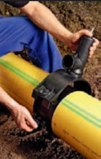
Anbohrarmatur aufsetzen.
