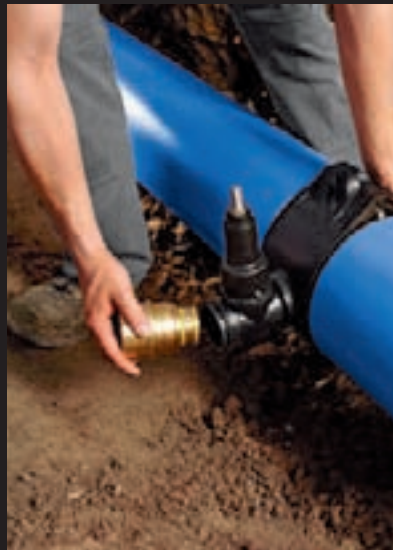
Geopress-Abgangsstutzen einsetzen.
