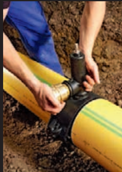
Geopress-Abgangsstutzen einsetzen.
