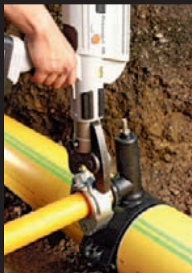
Anschlussleitung verpressen. Druckprobe.
